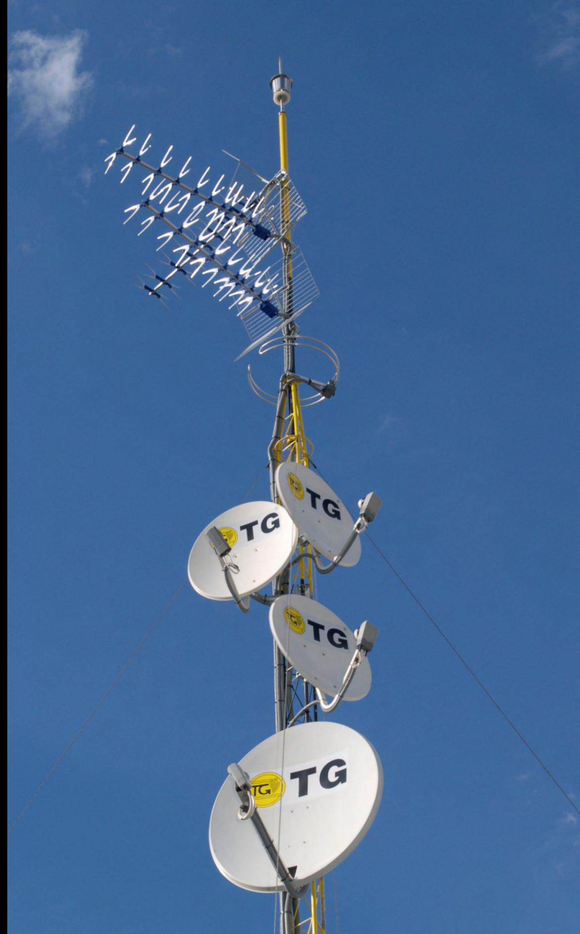
▲ Estación receptora de señales de TV, satélite y radio, con protección electromagnética
